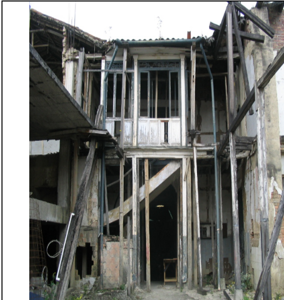
Parte interior del frente del inmueble
