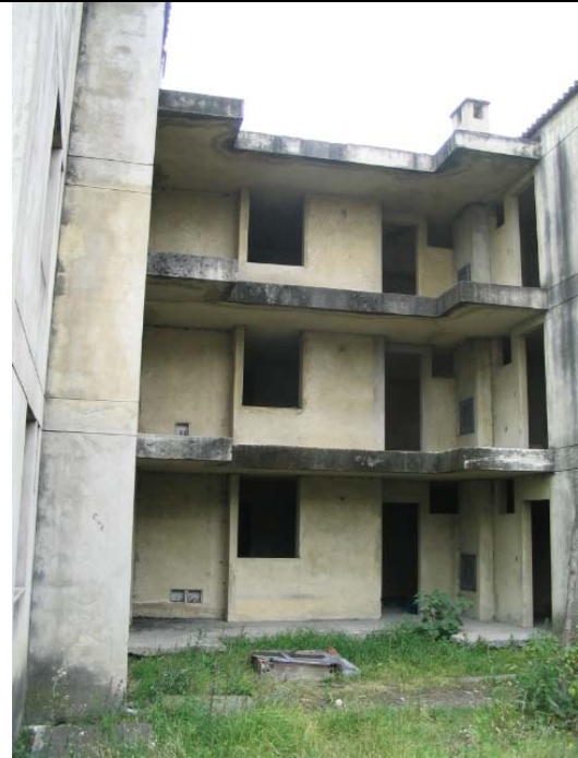
Interior del proyecto en obra gris
