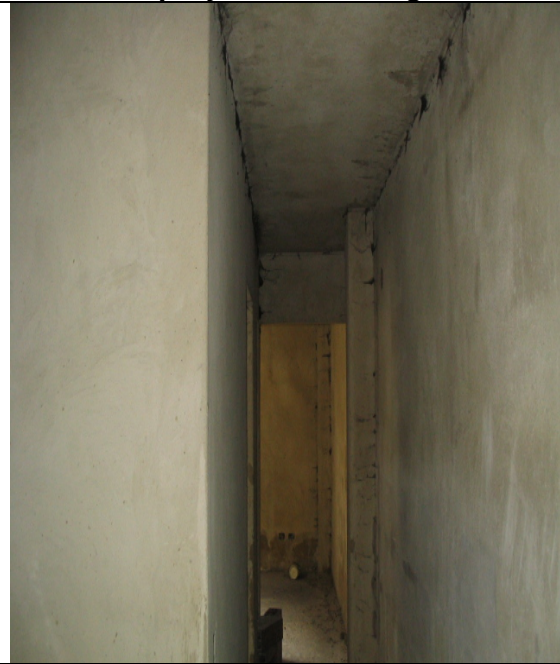
Interior de las unidades sin acabados
