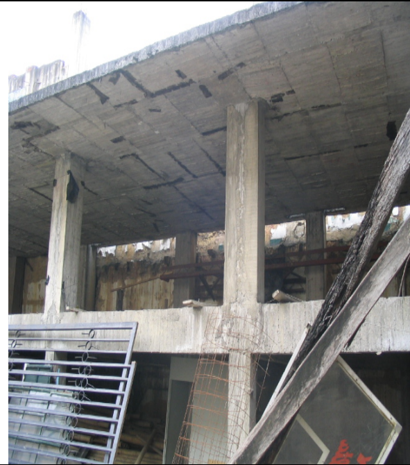
Estructura parte occidental
