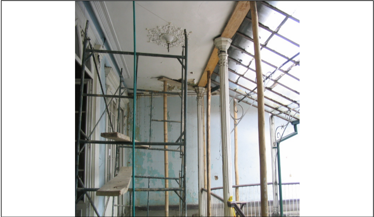
Ejecución estudios para restauración
