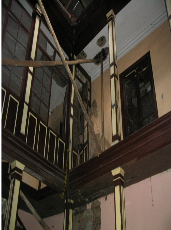
Interior apuntalado para restaurar
