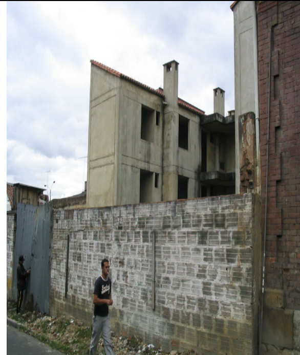
Entrada a la edificación
