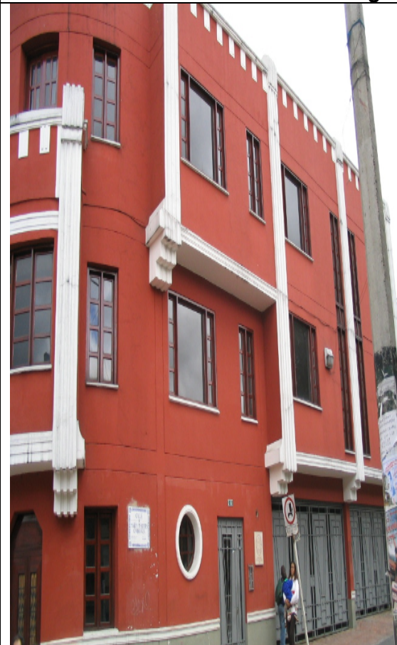
Fachada del edificio
