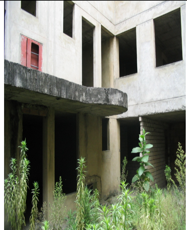
Estructura en concreto
