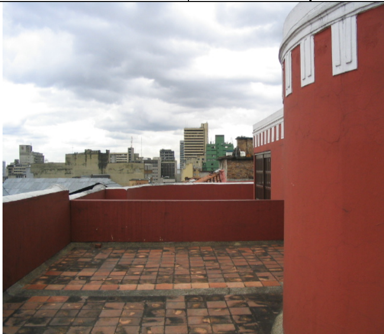
Terraza del edificio
