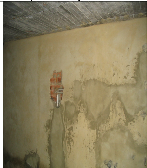
Habitación en obra gris
