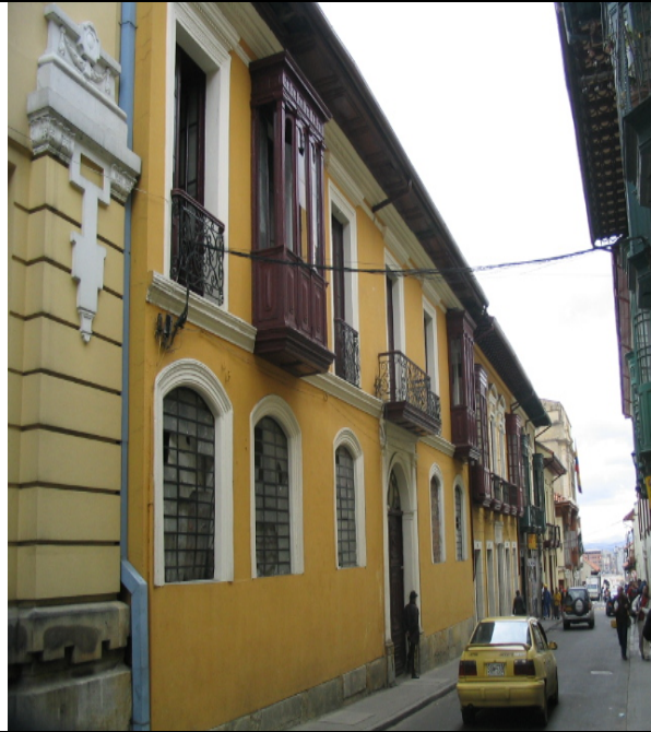
Fachada del inmueble
